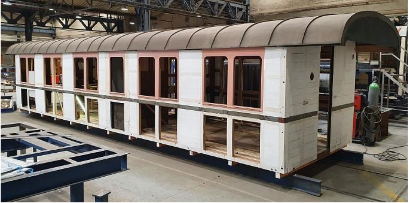
Die Arbeiten am Holzkasten sind beendet und die ersten Bleche montiert.
