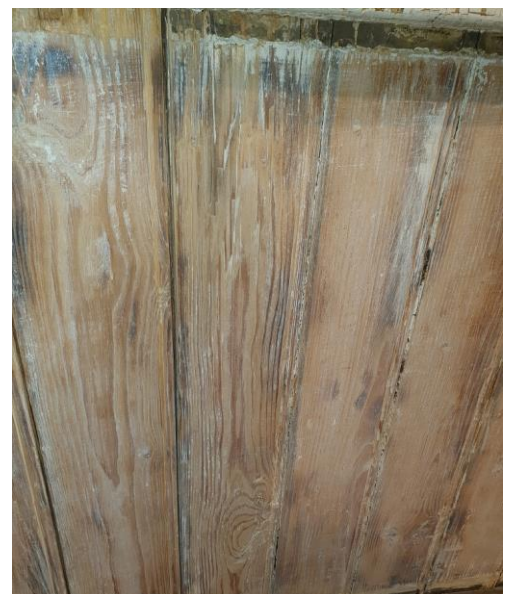
Abföhnen der alten Farbe (noch ersichtlich an den zwei hinteren Reihen) Aufarbeiten der Doppelfalze am Dachtäfer
